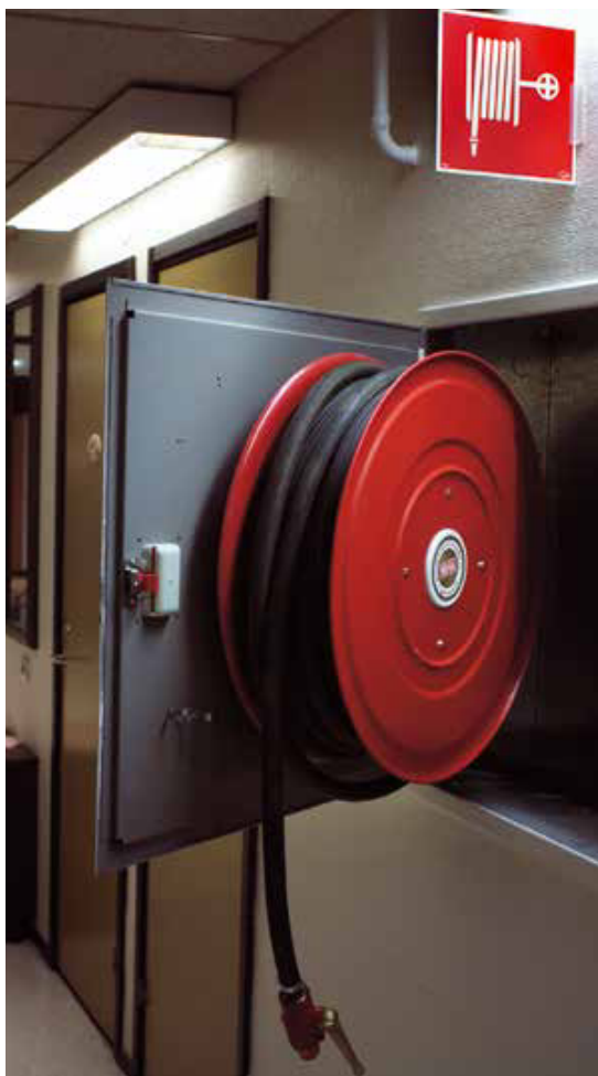
En vattenslang i styv plast är lätt att hantera och finns alltid på plats.
